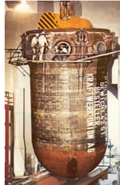
Druckbehälter des KKW Gösgen
